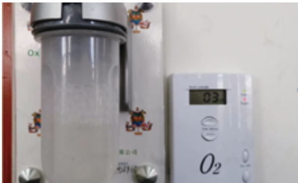
西藏公司在平均海拔 5000 米以上的日喀则地区仲巴县分公司职工之家安装制氧设备
