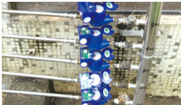
2017年3月，深圳水务（集团）有限公司在福田区景田北小区部署安装NB-IoT智能水表
