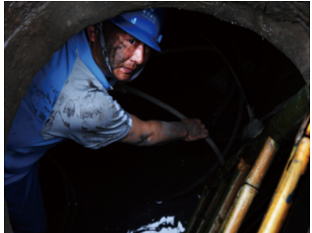
——合肥市分公司装维经理 余国友 2017年7月28日，合肥市分公司装维经理余国友在黄山路地下5米的窨井中修复光缆
