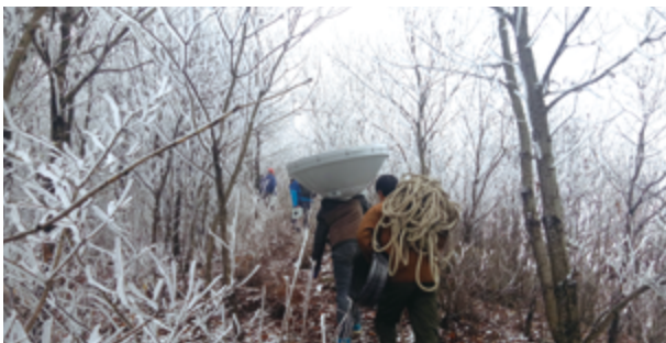
2017年1月1日，工程人员徒步向百莲村运送器材开展宽带建设
