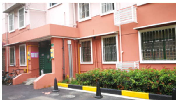
实施线路整治后的临汾小区一角
